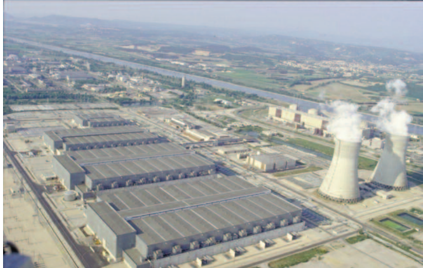
Usine Georges Besse d'Eurodif Production sur le site du Tricastin
